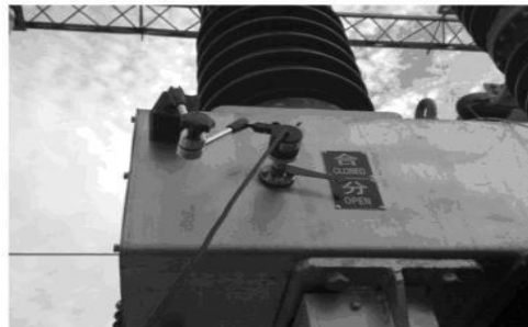
35KVSF6 开关传感器安装
